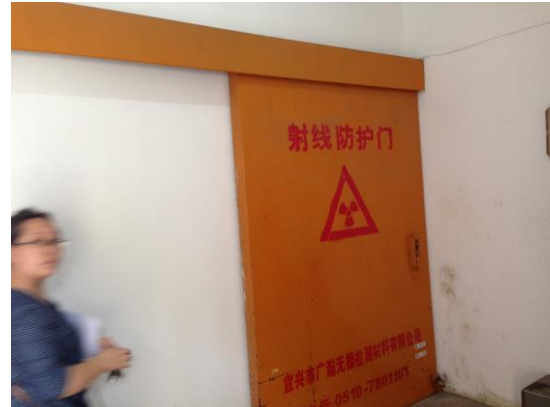
图 7-2 储源库电动门
