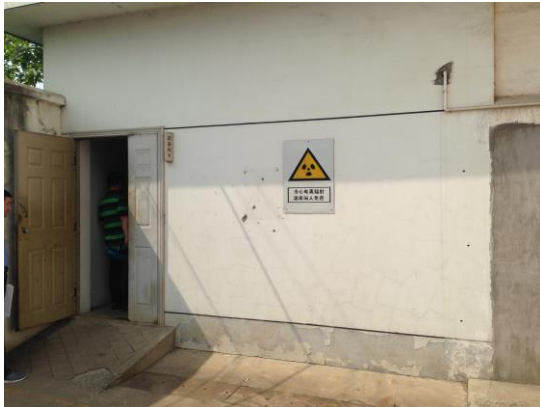
图 7-1 储源库外墙电离辐射标志
