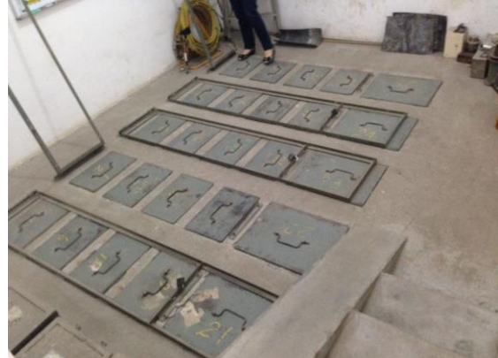
图 7-4 储源库内储源坑
